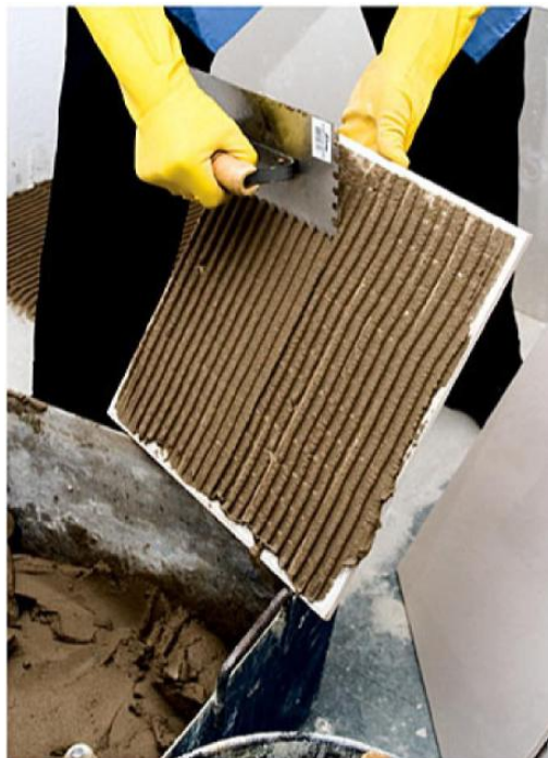
Figura 11 – Aplicação da argamassa no tardo de da peça cerâmica
