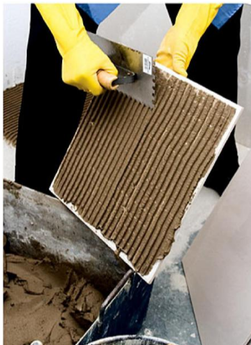
Figura 5 – Aplicação da argamassa no tardo da peça cerâmica
